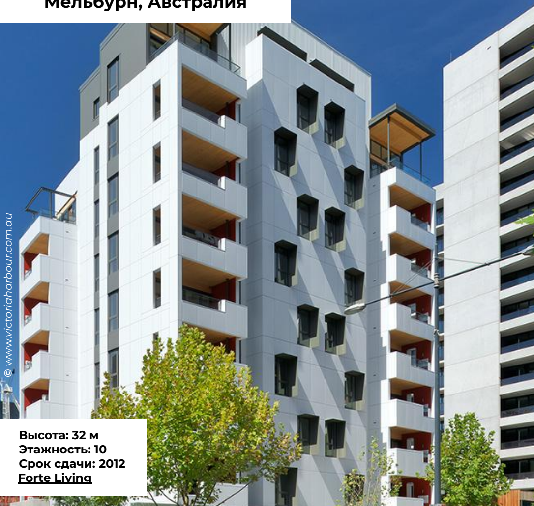
Жилое здание Forte Living, Мельбурн, Австралия
